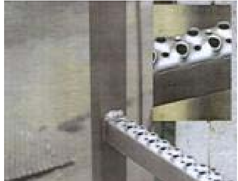
Abb. 11 Sprosse mit besonders rutschhemmender Trittfläche
