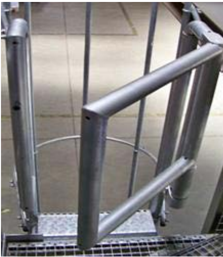
Abb. 22 Ausgleichsstufe aus Riffelblech zur Spaltverkleinerung
